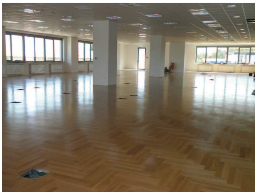
Slika 1: Pogled na dio prostora cjelovite podne plohe veličine ca 1000 m 2 koji se ne može pravilno obložiti drvenim podom bez ugradnje razdjelnih (dilatacijskih) reški
