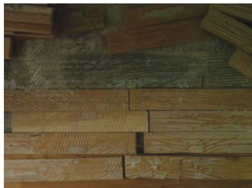
Slika 4 (desno). Rub poda se odize: parna brana i ljepljivo su nanešeni pravilno, u odgovarajućem sloju, pa lom nastaje kohezivski u sloju ljepljiva.
