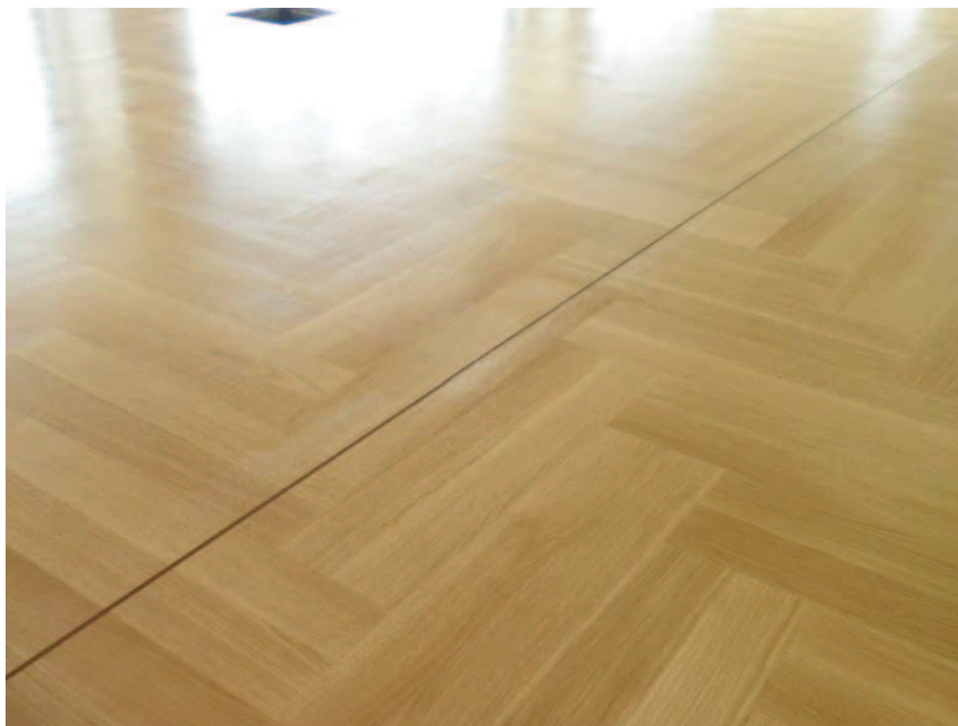
Slika 8. Razdjelna reška načinjena propiljivanjem zapunjena je trajnoelastičnim kitom te polakirana u cjelini s parketom. Tamnija boja kita odabrana je da se manje uočavaju možebitne kasnije greške laka na spojevima.
