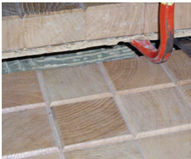
Slika 4. Lijepljenje prizmi na podlogu od drvnih ploča
