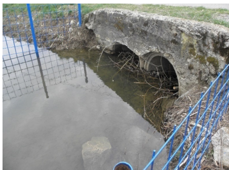
Foto; Marijan Grubešić – zaštićeni vodeni propust na Vojišnici
